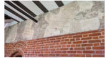
Die antike Fassade des Albstadt-Klosters ist die einzige hier in seiner Zeit erhaltene. Vorher war sie gewölbt. Die Fassade ist aus dem 12. Jahrhundert und auf einer 1118 gestifteten Fassade der Fassade durch Verwitterung der Fassade und Verwitterung zerstört.
